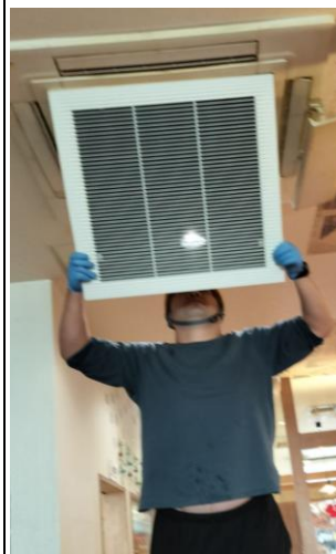
エアコンフィルターの交換と清掃
